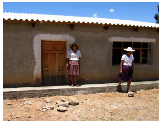
A la derecha, doña María enseña la grada de hormigón que la comunidad acaba de hacer alrededor del galpón para protegerlo del agua. A la izquierda, doña Fanny recuperó ladrillos y los puso... ¡sobre los ladrillos de la UMSS!
